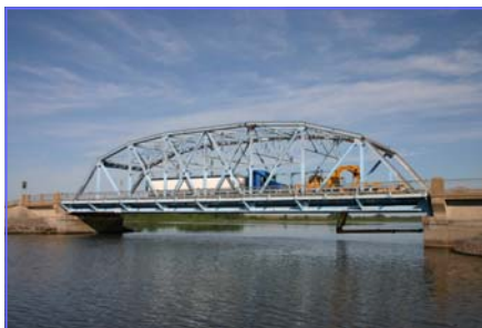
Lac Qui Parle Bridge (No. 5380), Minnesota.
